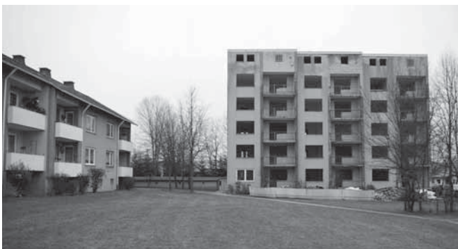
Buchwalder Weg alt – in die Jahre gekommene Wohngebäude am Stadtrand.
