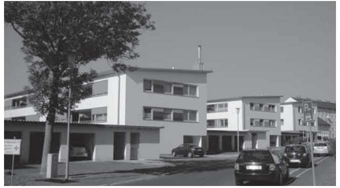
Neue Wohngebäude im Ortsteil Vorwerk sind bestens isoliert und werden mit Geothermie oder Hackschnitzeln beheizt.
