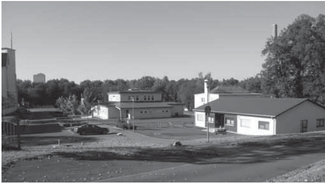
Ludwigsmühle neu – das Gelände ist nach Abbruch der alten Fabrik bereits wieder mit neuen Gewerbebauten belegt.
