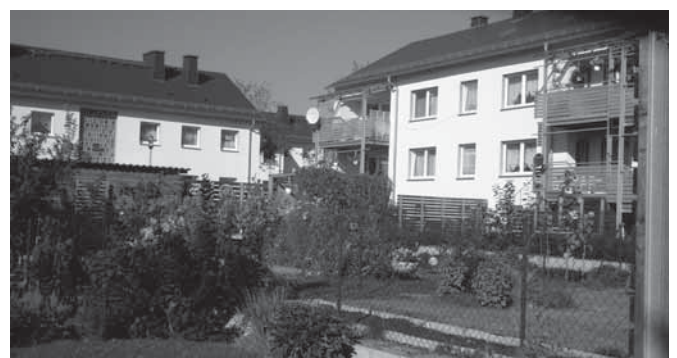
Buchwalder Weg neu – nach Teil-Abbruch und Aufwertung des Wohnumfeldes.
